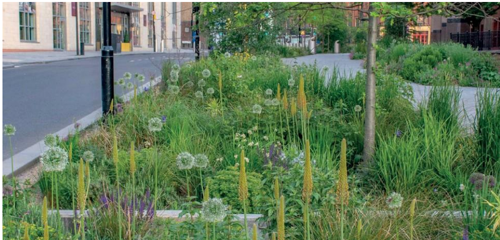
Gardd law o lwyd i wyrdd Sheffield, sy'n darparu system ddraenio gynaliadwy i ddal dŵr ffo ac i wella bioamrywiaeth canol y ddinas Ffynhonnell delwedd: Nigel Dunnett
