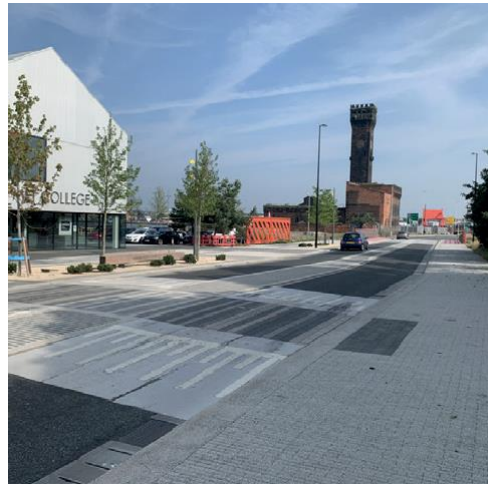
Croesfan wedi'i godi i gerddwyr, strided canolog a phlannu coed, yr A554 Tower Road ym Mhenbedw.
