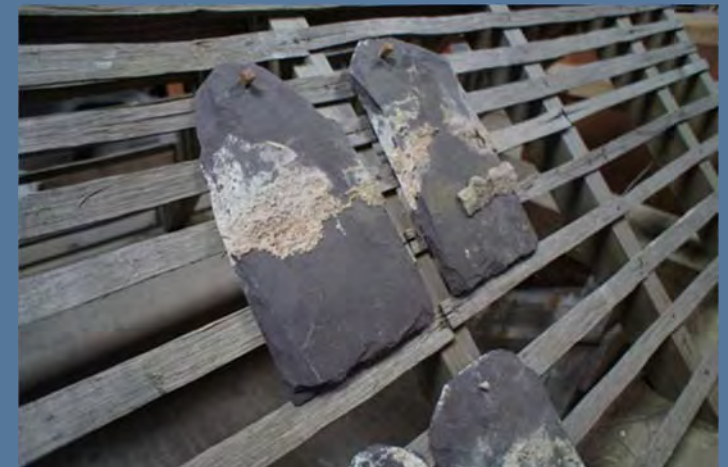
Uchod: To llechi â hoelion traddodiadol sy'n para am ganrifoedd a gellir ei atgyweirio'n hawdd.
