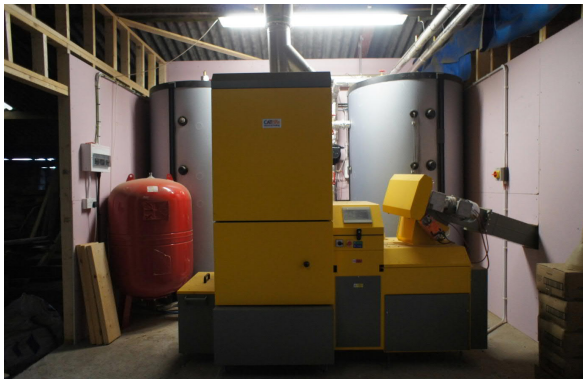
Uned 110kw yn gwasanaethu clwstr o ffermydd ger Llanrwst
